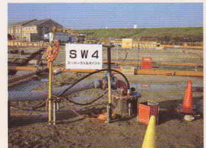
スーパーウェルポイント設置状況
