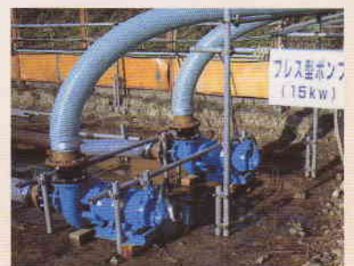
中間圧力ポンプ設置状況
