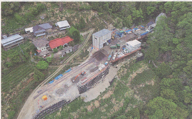
ドローン撮影した作業ヤード(鉄建建設提供)
