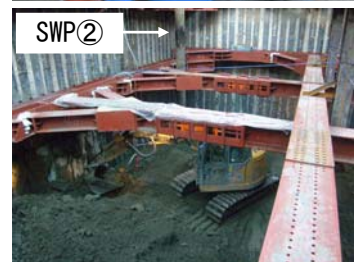
写真1 真空排水状況(上) 5次掘削状況(下)
