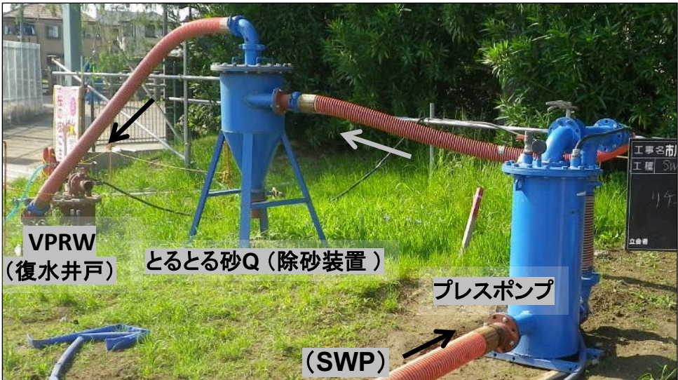
市川市菅野下水処理場建設工事（千葉県）（日本下水道事業団発注）
