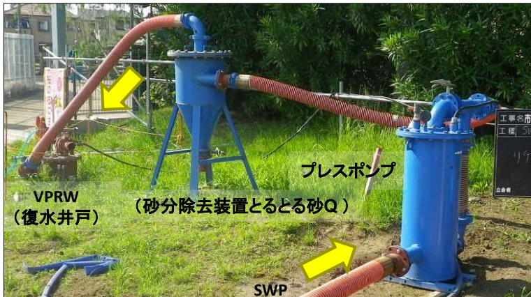
① 盤ぶくれ対策、復水 (日本下水道事業団発注、市川市菅野下水処理場建設工事、平成25年)
