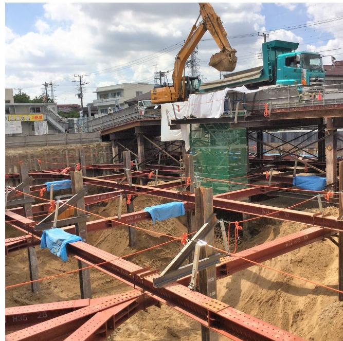
⑤ 開削工事のドライワーク、復水（建築）
