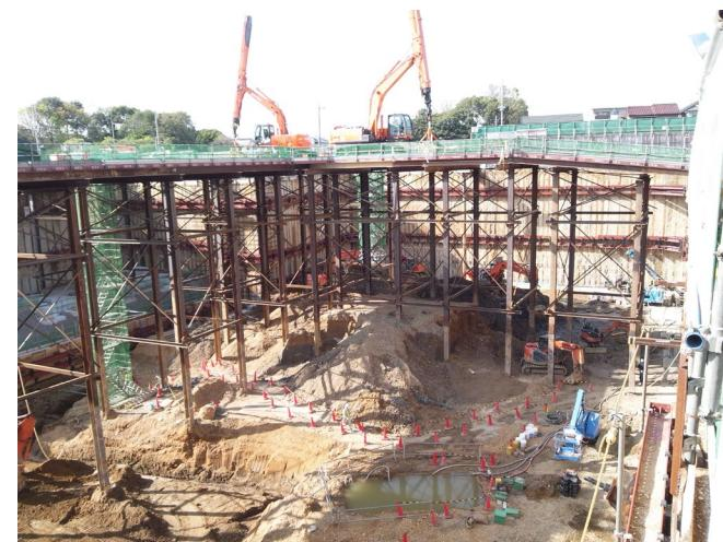
④ 盤ぶくれ対策、ドライワーク、復水（建築）
